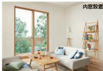
今ある窓にプラスして新たに内窓をつけることで断熱性能をアップ。内窓のガラス仕様にこだわることで、さらなる高断熱化も行えます。
